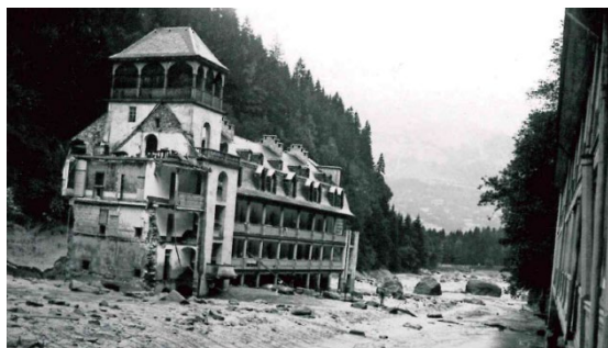
Ce qu'il reste de l'établissement thermal après la catastrophe de 1892. On aperçoit les gros blocs arrachés et emportés par le flot.
