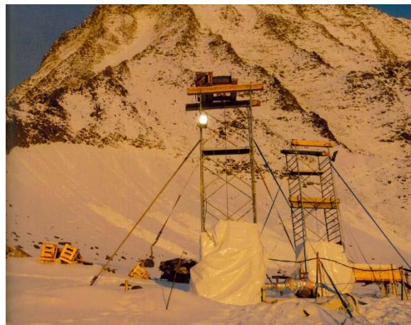
Tours de forage installées en 2010 sur le glacier
