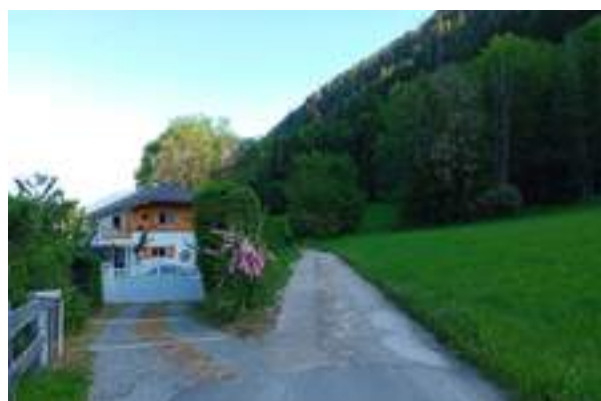
CHEMIN DE BOCANCEY, EMPIÉRÉ AVANT LES TRAVAUX DE GOUDRONNAGE
