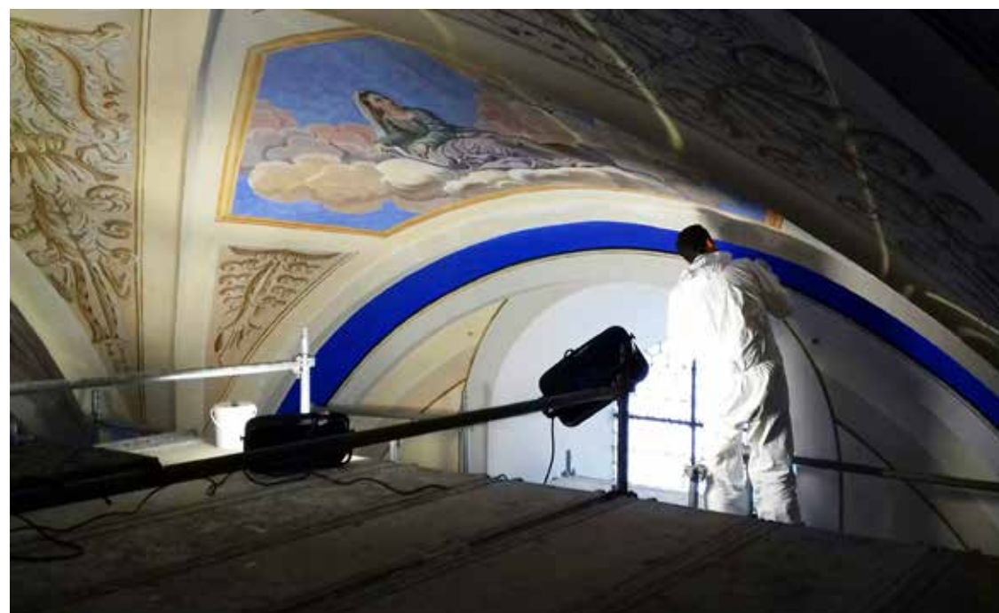
Nettoyage des voûtes
