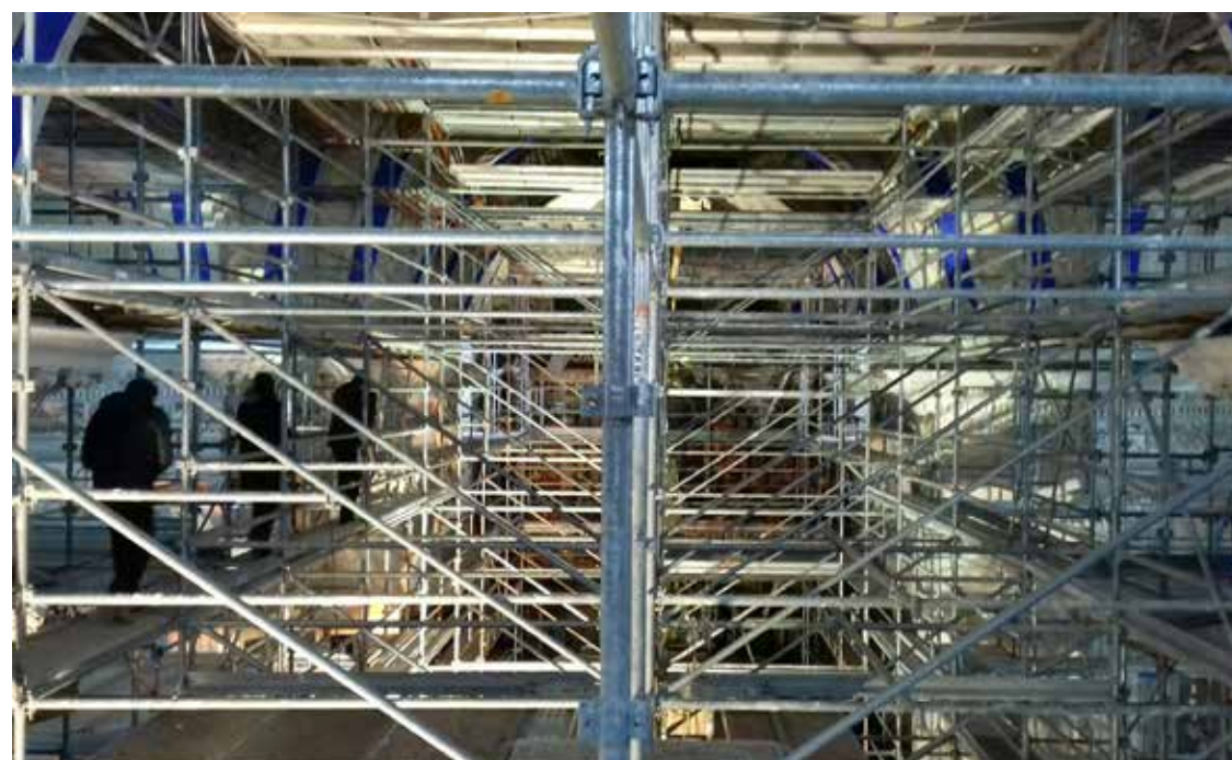
L'ensemble de l'église a été échafaudée
