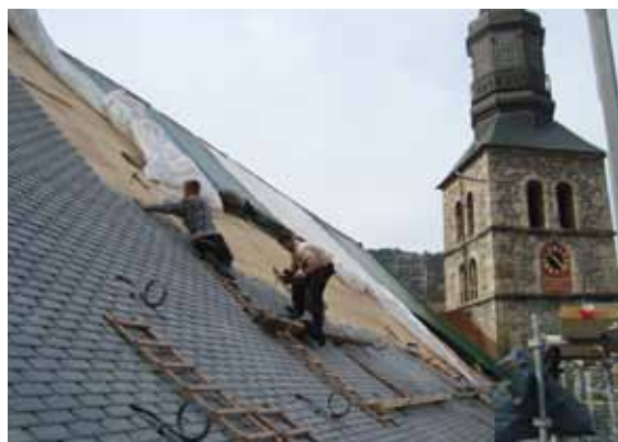
Les travaux de rénovation du toit de l'église
