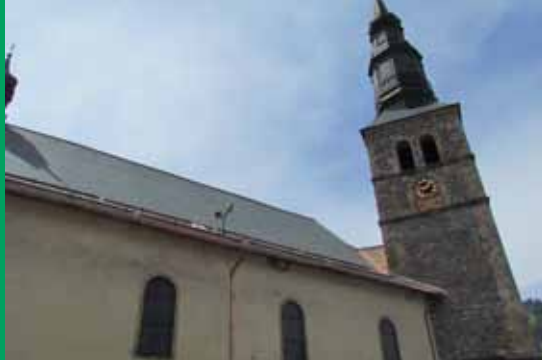
UNE TOITURE NEUVE POUR L'ÉGLISE DE SAINT-GERVAIS
