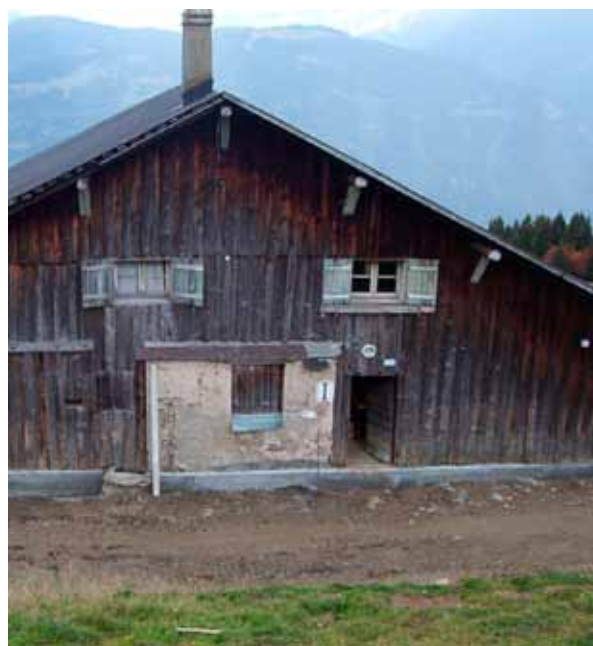
Le chalet de l'Avenaz avant travaux
