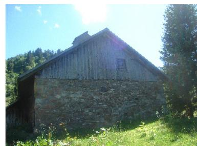
*Façades recouvertes de bardage en couenneaux*
