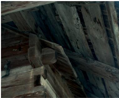
Les lames non jointives laissent souvent apparaître la couverture : cet aspect épuré doit être conservé.
