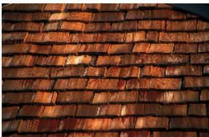
Mise en oeuvre par pose manuelle de chevilles de bois avec vilebrequins et grive après calibrage des tavaillons par le banc d'âne et la panne, puis mise en place par clouage ou agrafage sur un support de liteaux ajouré et ventilé sur 3 à 4 épaisseurs suivant la pente du toit.
