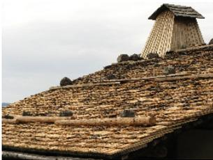
Couverture réalisée avec des lames de bois, prenant une teinte gris argenté avec le temps.
