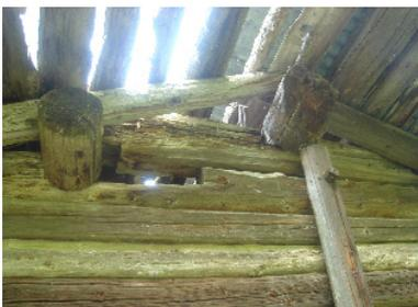
*Charpente dégradée suite au défaut de couverture*
