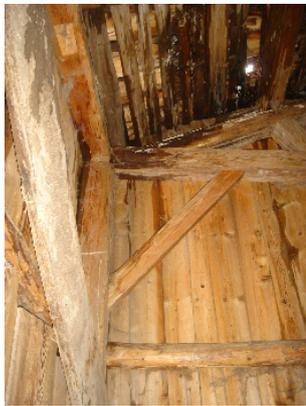
*Dégradation de la couverture entraînant des infiltrations au niveau de la structure*
