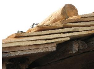
Mise en œuvre par pose manuelle non clouée sur un support de lattes maintenues par des barres de bois et des grosses pierres.
